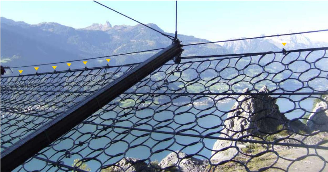
La fune di bypass è connessa ad entrambe le funi di supporto con grilli da 7/8" lungo la sezione dove anche la rete ROCCO® è connessa alle funi di supporto. La distanza fra i grilli non deve essere maggiore di 1,5m.
