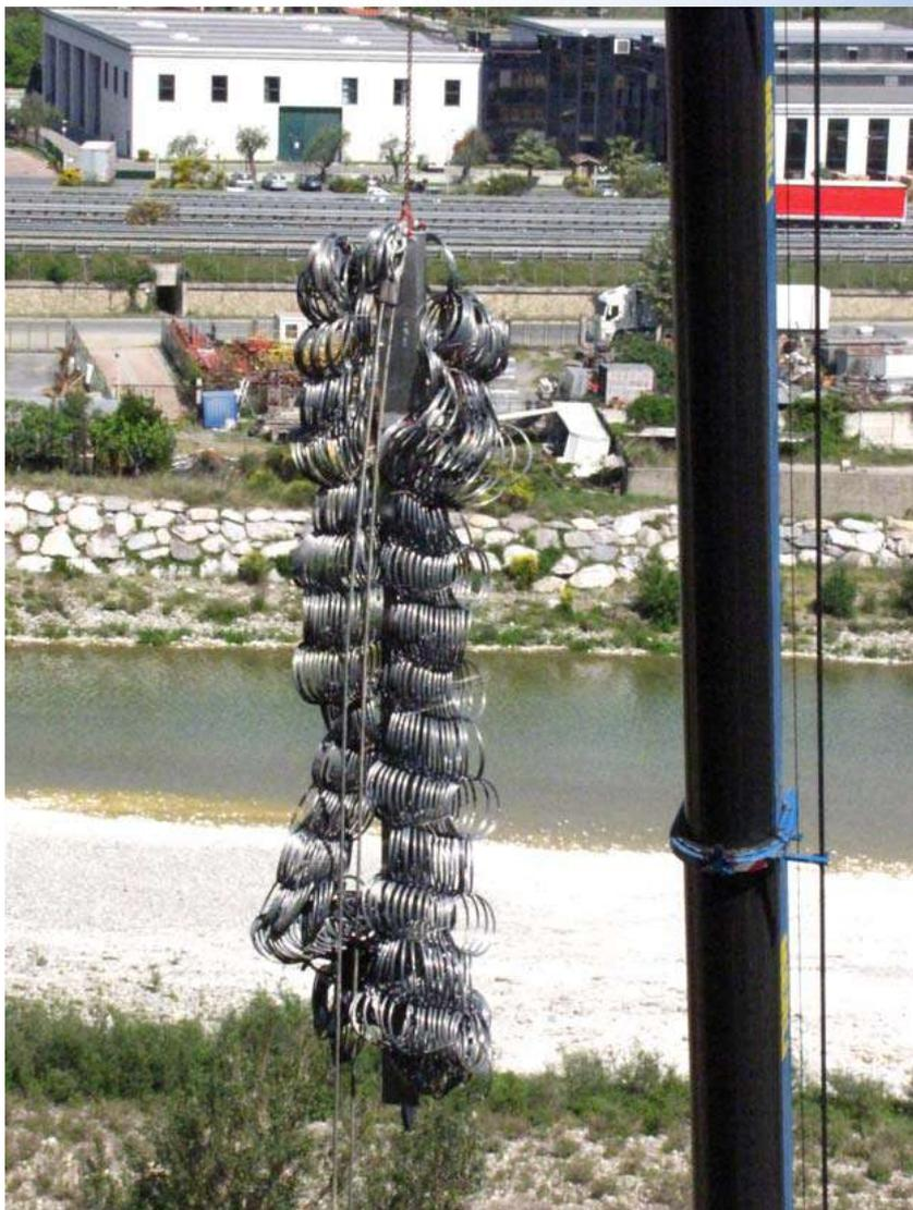
In relazione alle capacità portanti della gru, preassemblare le single parti sul montante.
